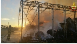
Rogo nel capannone, in fiamme oltre 5mila quintali di fieno
